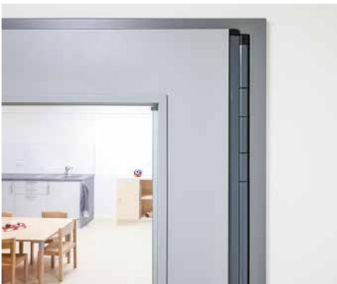
防夹手门 Super Secure 由于合页和密封系统直接集成在门框和门扇中，因此能够更最大限度地保障安全性。
